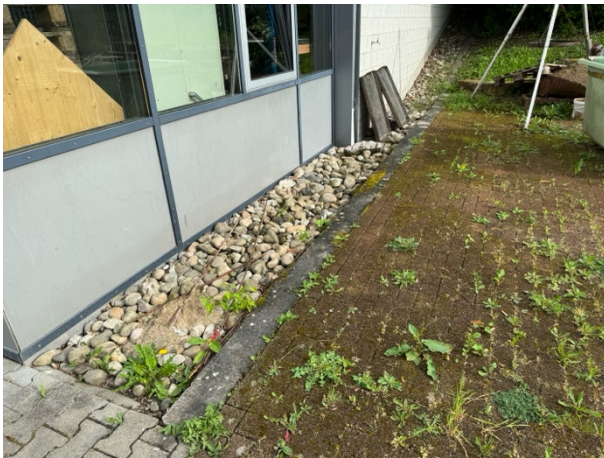
Abb. 12: Wand des Bestandsgebäudes ist mit grobkörnigen Kieselsteinen als Schlammspritzschutz.
