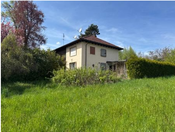
Abb. 14: Blick auf das abzubrechende Bestandsgebäude aus Südosten.
