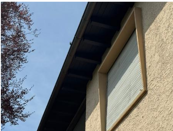
Abb. 24: Unbenutzte, ungestörte Rolllädenkästen sind potentielle Fledermausquartiere.
