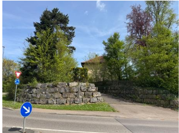
Abb. 15: Zufahrt zum Bestandsgebäude mit flankierenden Blocksteinmauern.
