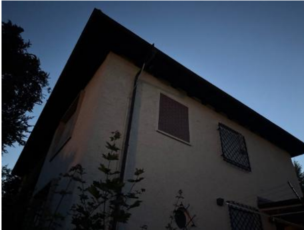
Abb. 38: Zur Ausschwarmkontrolle observiertes südöstliches Eck des Bestandsgebäudes.
