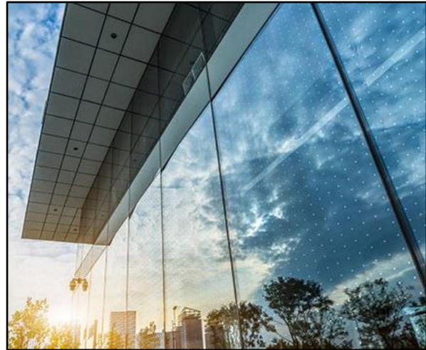
Abb. 10: Glasfassade mit Punktmuster, Quelle: SEEN AG
